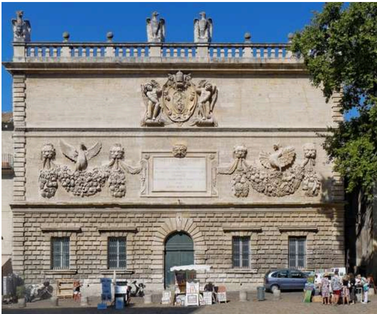
Façade de l'hôtel des Monnaies, à Avignon.
