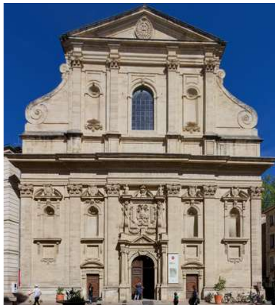
Ancienne église du collège des Jésuites, actuel musée Lapidaire, 27 rue de la République, Avignon.
